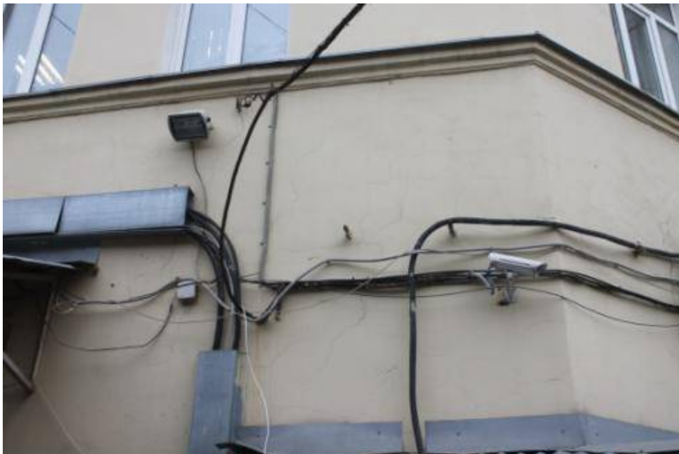
Фото 14. Система волосяных трещин в штукатурном слое, фасад по оси "А".
