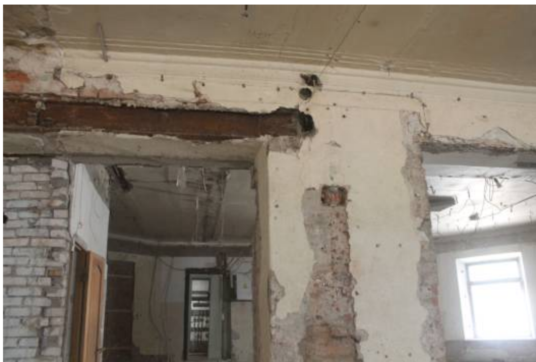
Рис.5.1. Общий вид опор и перемычек.
