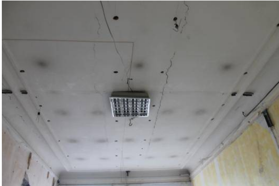
Рис.5.6. Характерные швы в штукатурке в местах установки балок перекрытий
