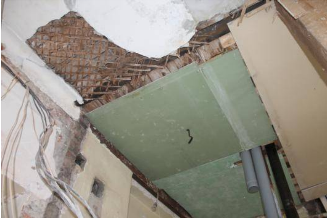
Рис.5.4. Состав перекрытия, металлические балки.
