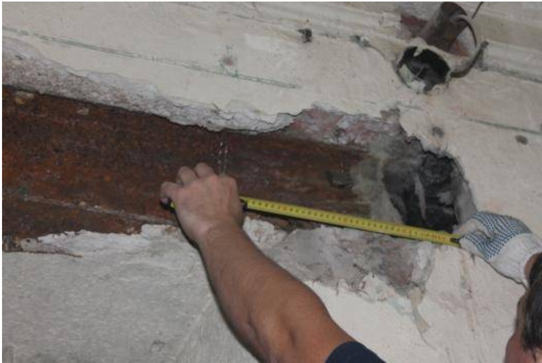
Рис.5.2. Глубина опирания главных балок на колонны 350 мм.
