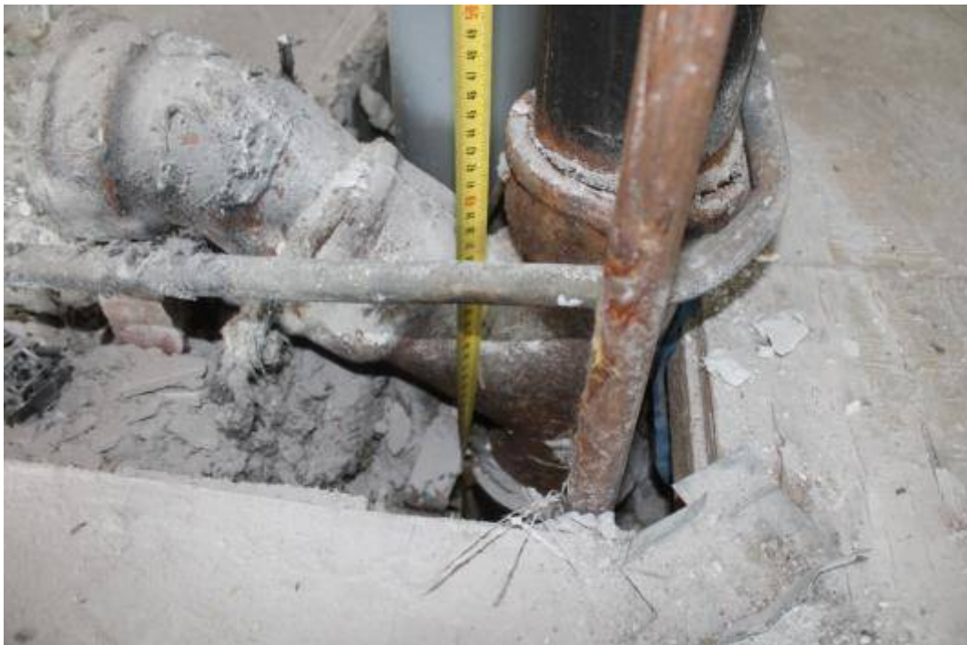
Рис.5.4. Состав перекрытия, металлические балки.
