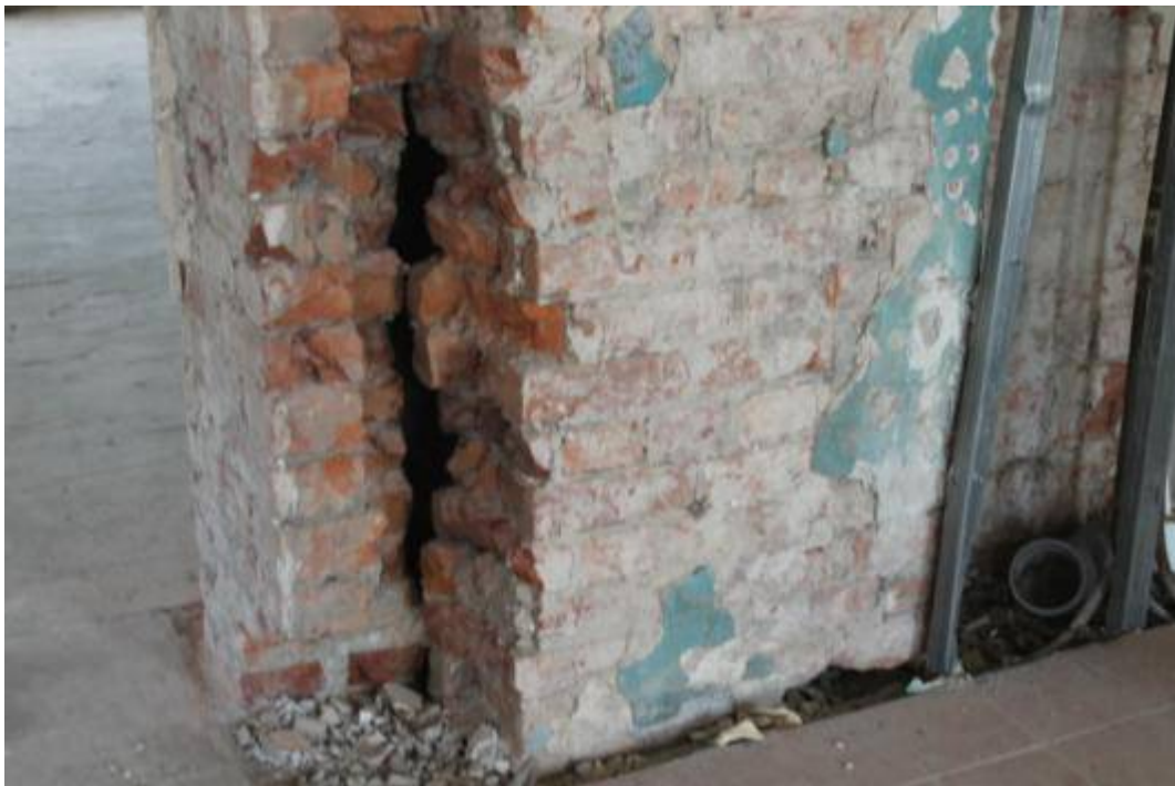
Рис.5.3. Вентканалы в кирпичной кладке.
