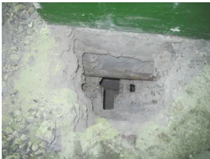
Фото 6.1. Вскрытие пола перекрытия (В-6)
