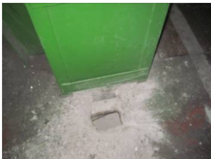
Фото 6.2. Вскрытие пола перекрытия (В-5)
