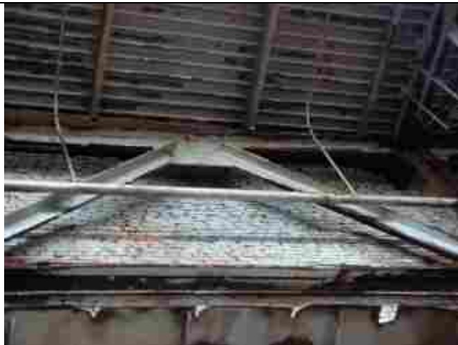
Стропильные фермы в осях «9-12/А-Д»
