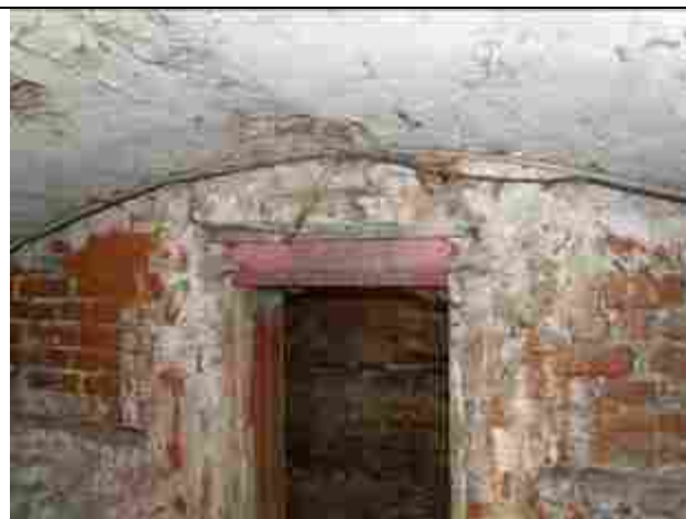
Фото 6.1.3. Проем в фундаменте в осях
