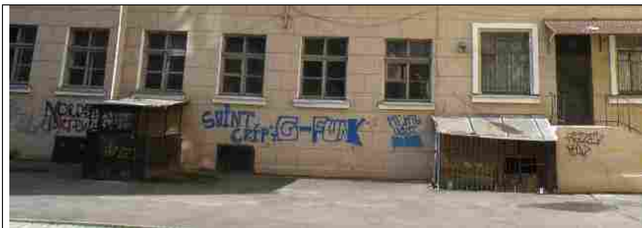
Фото 6.1.1. Проемы в фундаменте в осях «4–7/Д»
