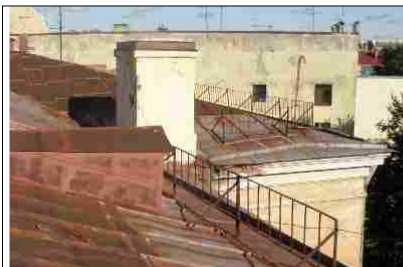
Фото. 6.2.1. Выход вентканала (дымохода) в осях «8/Е».
