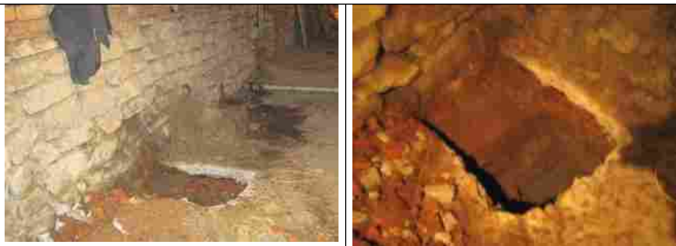
Фото. 6.1.2. Фото фундамента здания
