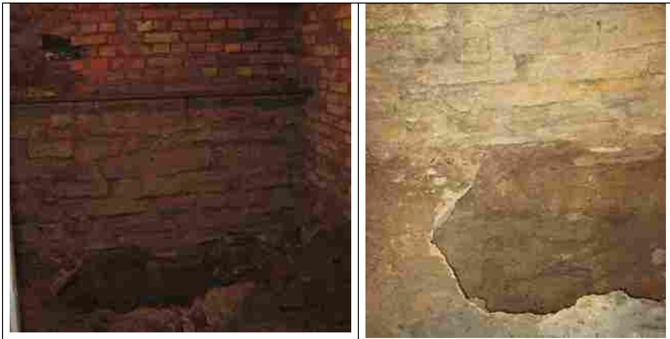
Фото. 6.1.1. Фото фундамента здания
