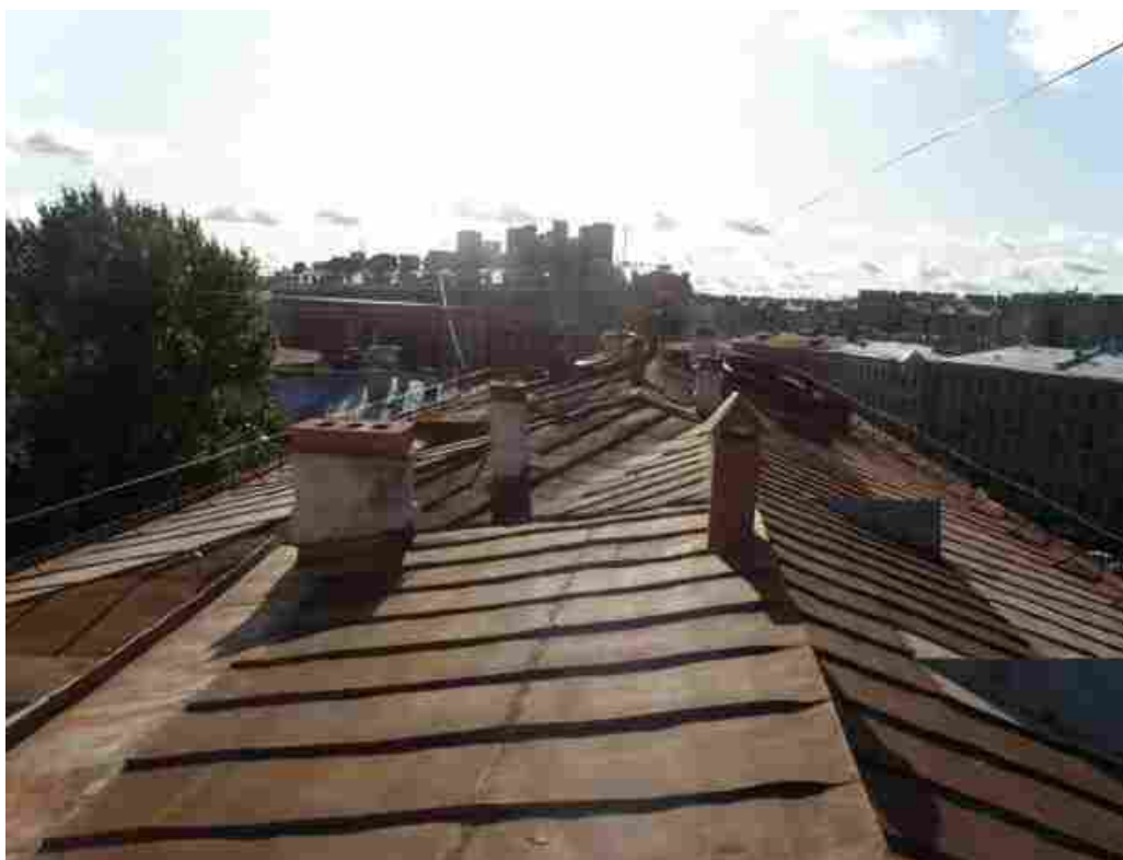
Фото.5.5.1. Вид крыши здания.
