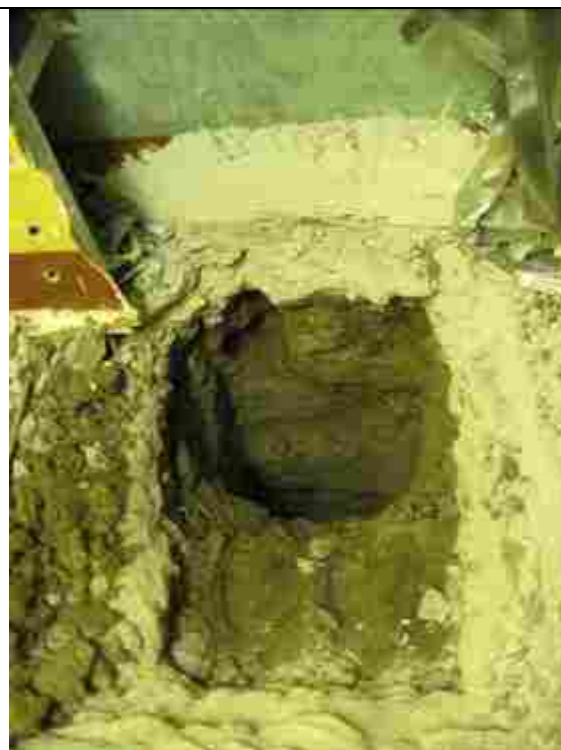
Фото. 6.1.4. Фото фундамента здания
