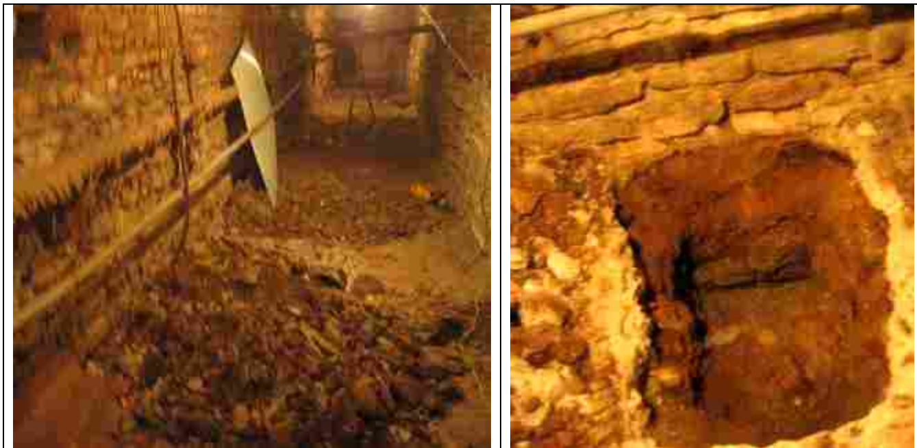
Фото. 6.1.3. Фото фундамента здания
