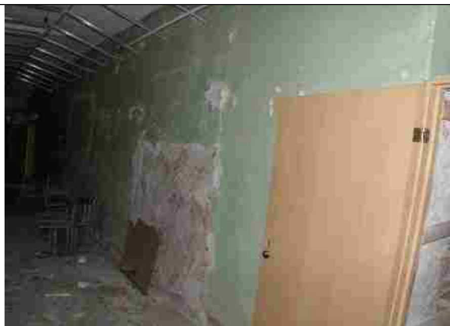
Фото. 6.2.3. Скрытые сквозные (дверные) проемы в стене в осях «9–11/Г».
