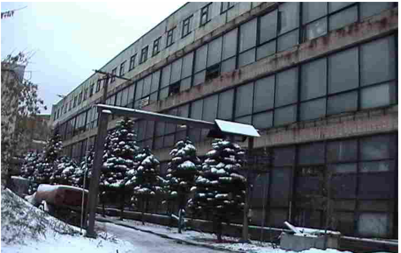
Общий вид здания.
