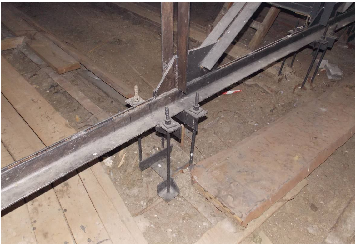
Фото 5.3.3. Общий вид крепления балок чердачного перекрытия к стропильным фермам здания.
