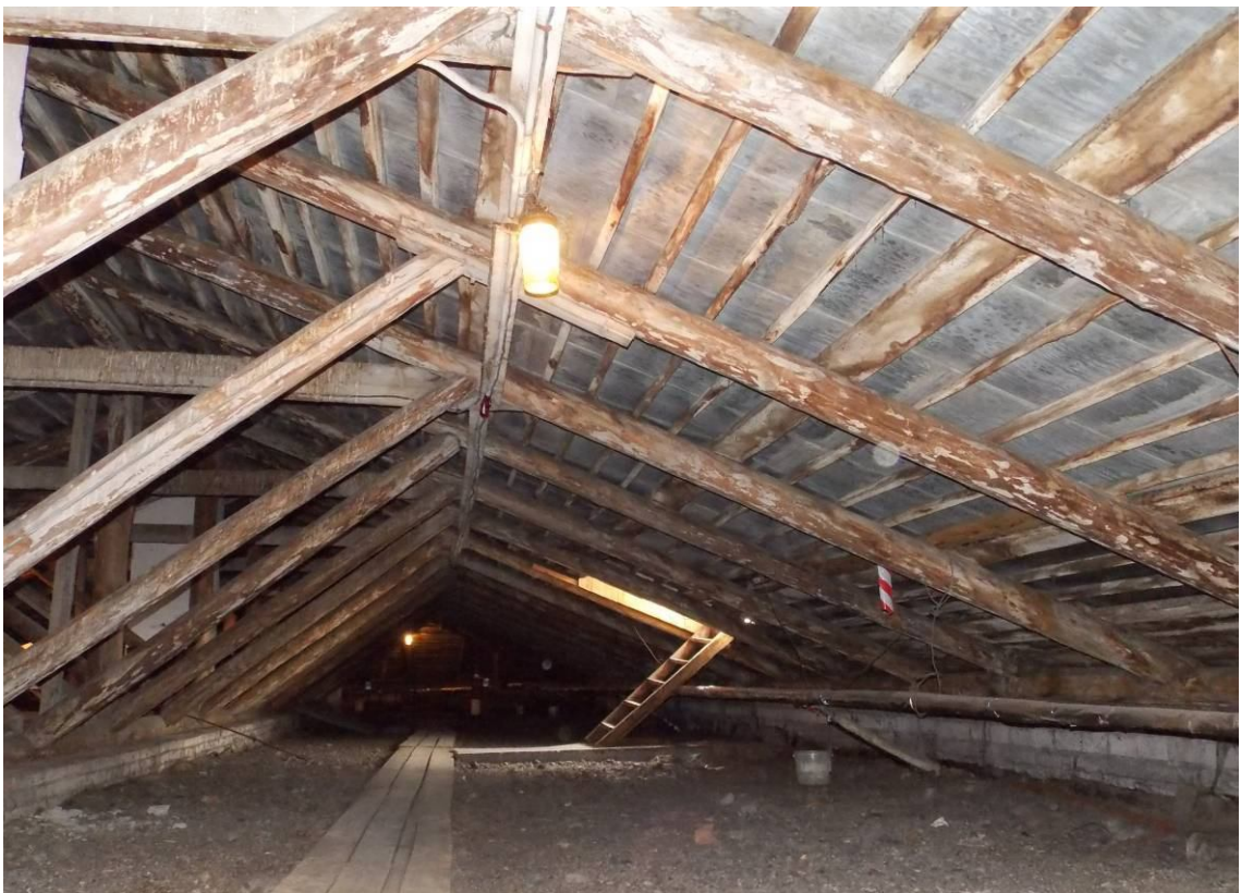
Фото 5.5.2. Общий вид конструкций крыши здания в осях «1-20/А-Г».
