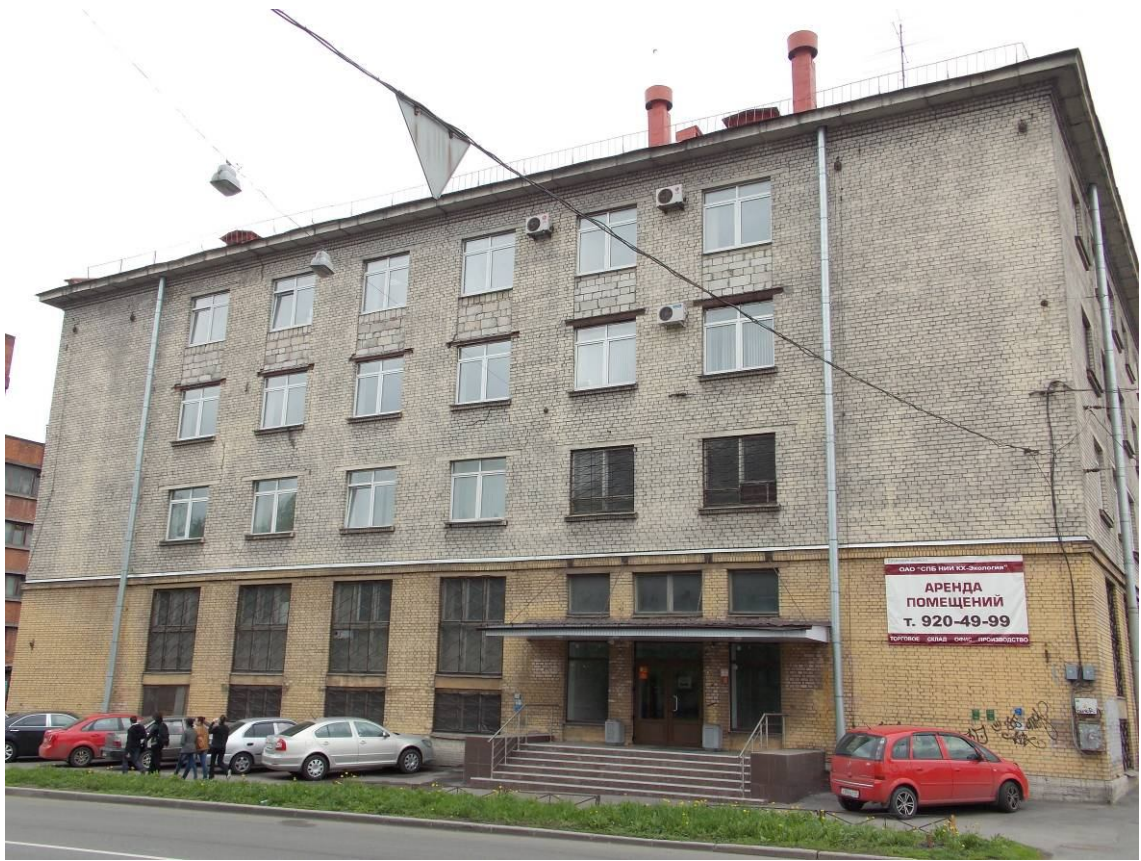
Фото 5.2.1. Общий вид фасадной стены здания.
