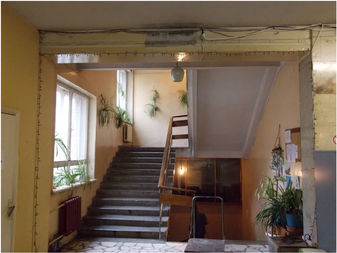
Фото 5.4.2. Общий вид лестничного марша в осях «4-5/В-Г».
