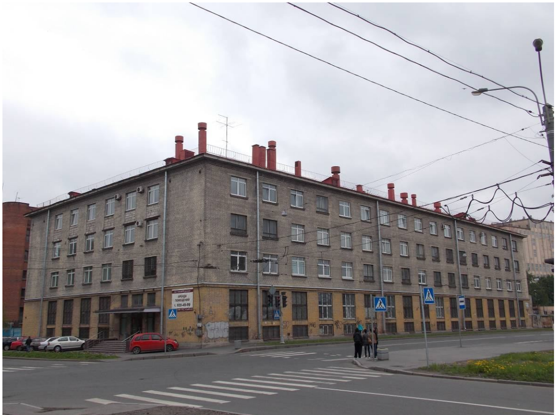
Фото 4.2. Общий вид здания.
