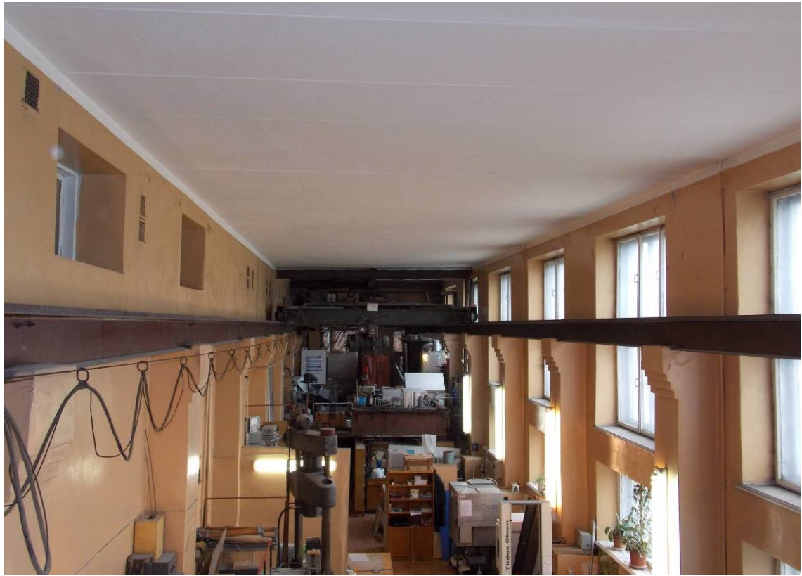
Фото 5.2.3. Общий вид кирпичных пилястр вдоль продольных стен в осях «А» и «Б».
