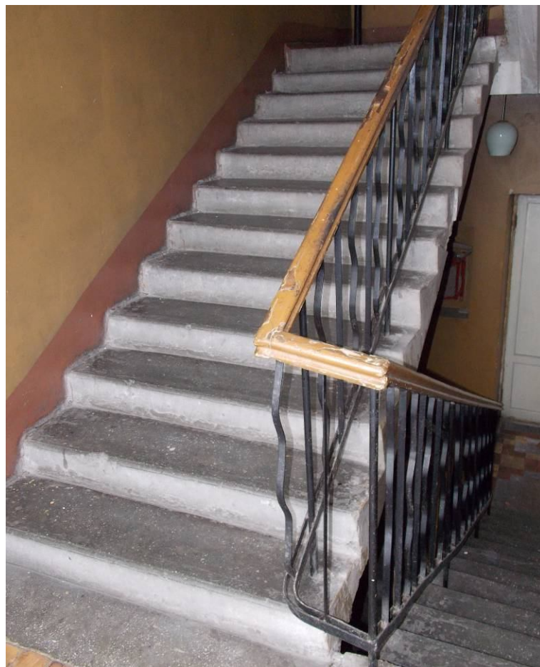
Фото 5.4.3. Общий вид лестничного марша в осях «18-20/В-Д».
