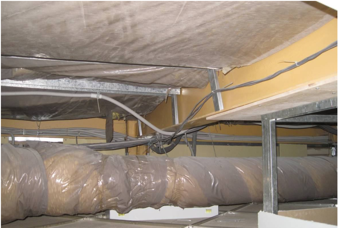
Фото 5.3.2. Общий вид конструкций монолитного перекрытия в осях «1-3/Г-Е».
