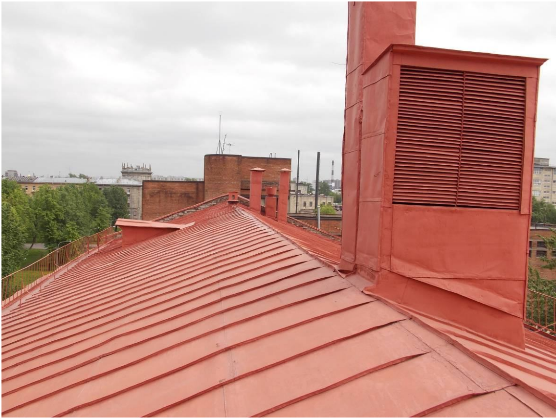
Фото 5.5.3. Общий вид кровли здания.
