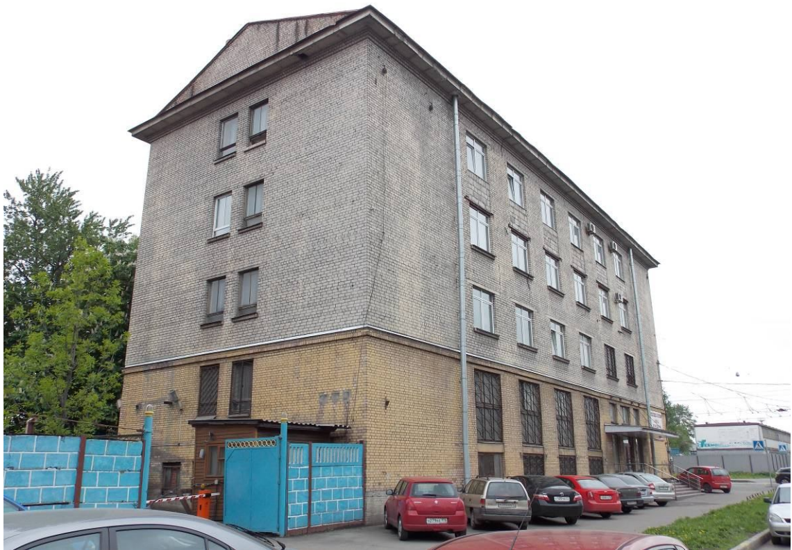
Фото 4.4. Фасад здания в осях «3-1/Ж-А».
