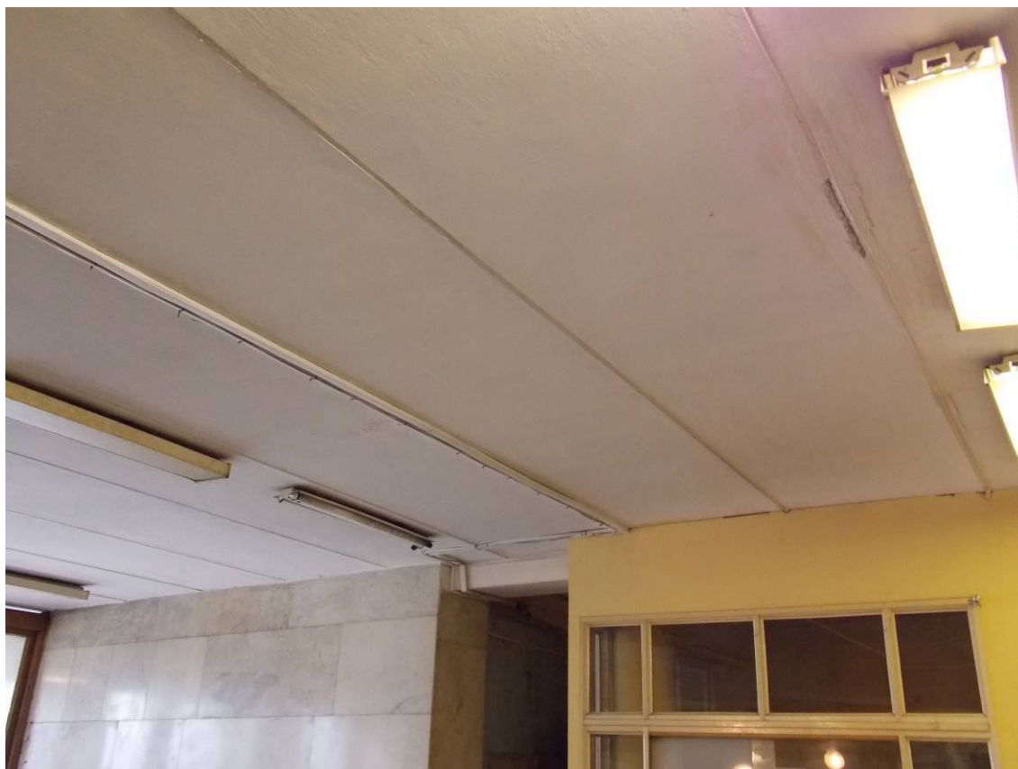
Фото 5.3.1. Общий вид сборных железобетонных плит перекрытия здания.
