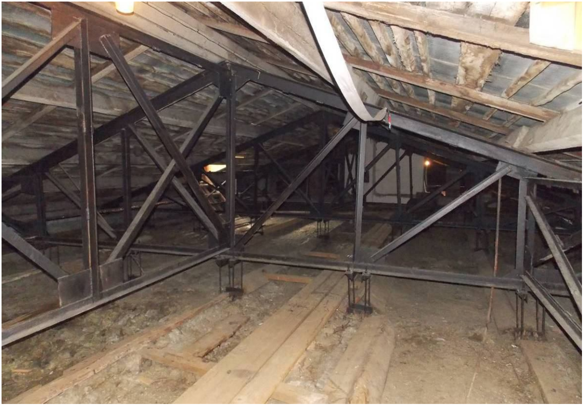
Фото 5.5.1. Общий вид конструкций крыши здания в осях «1-3/Г-Ж».
