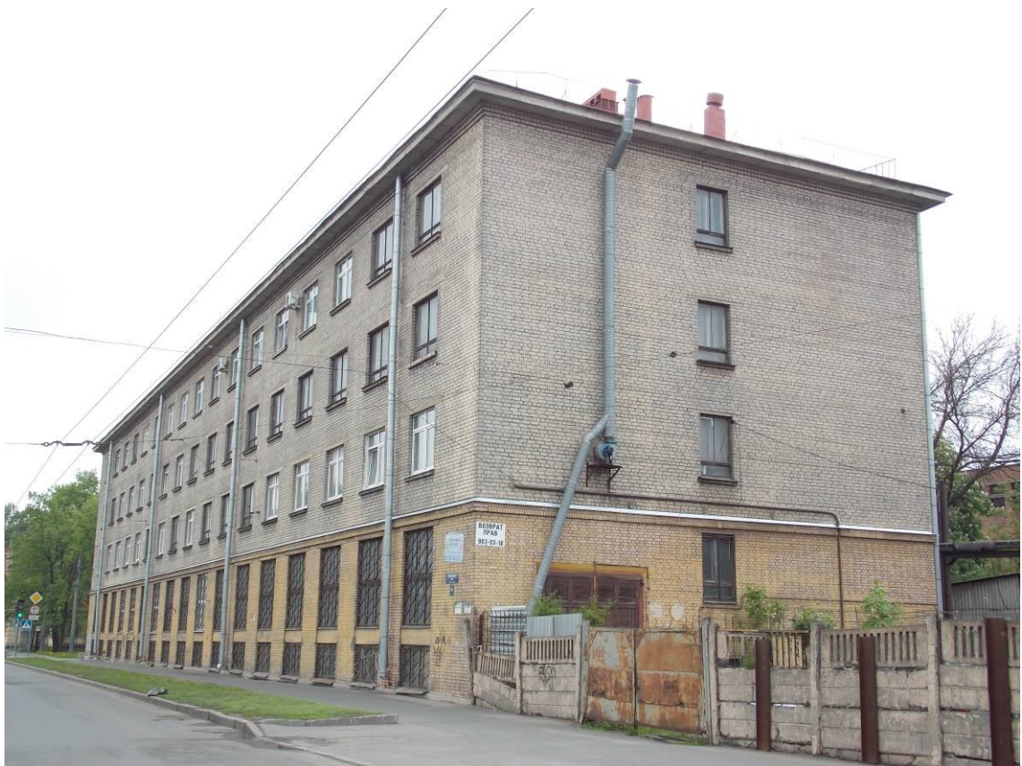
Фото 4.3. Фасад здания в осях «1-20/А-Д».
