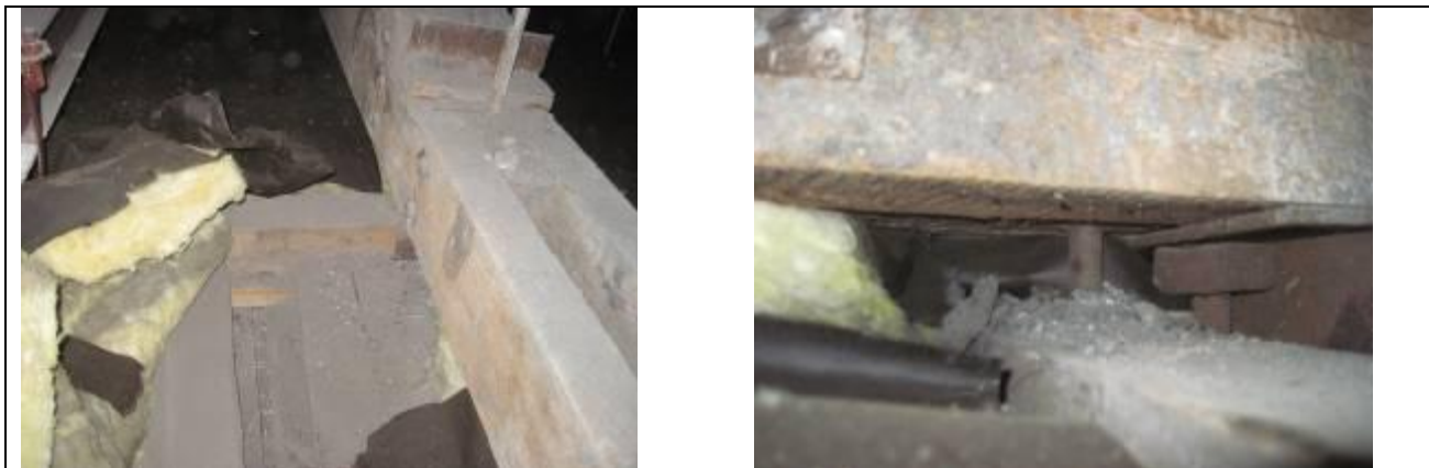
Фото 2.31. Подвесное перекрытие над пятым этажом (над спортивным залом) в осях «9-11/А-В»
