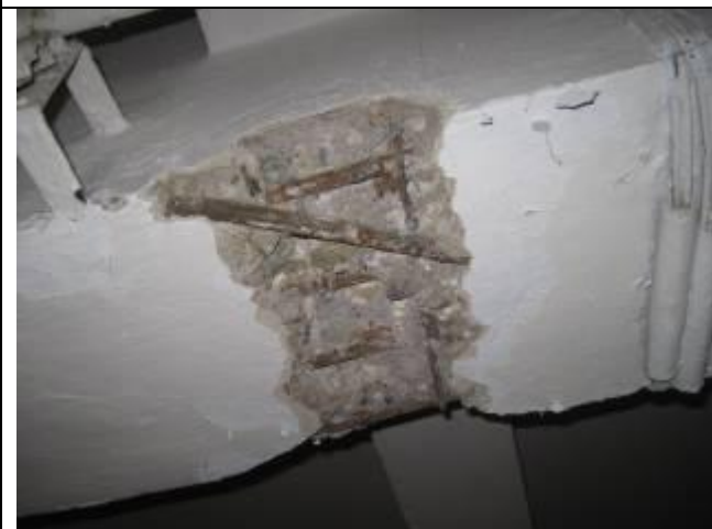
Фото 2.11. Главная балка ж/б перекрытия над вторым этажом в осях «8-11/Б-В»
