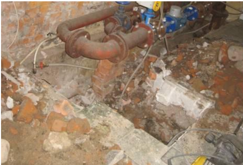
Фото 5.1.19. Фотофиксация шурфа, выкопанного в осях «9–10/А».
