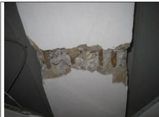
Фото 2.13. Главная балка ж/б перекрытия фойе над вторым этажом в осях «1-7/А-Г»
