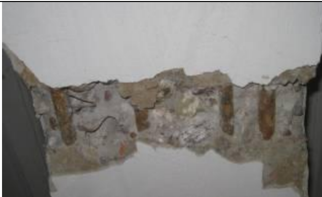
Фото 2.5. Главная балка ж/б перекрытия фойе над первым этажом в осях «1-7/А-Д»
