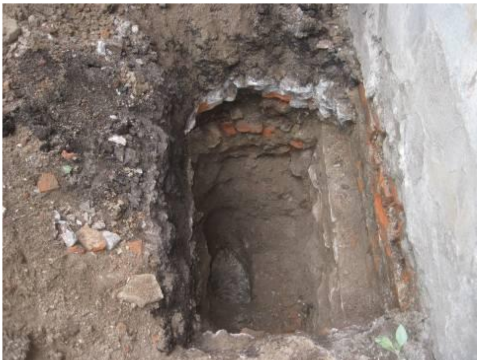
Фото 5.1.5. Фотофиксация шурфа, выкопанного в осях «10–11/Г».
