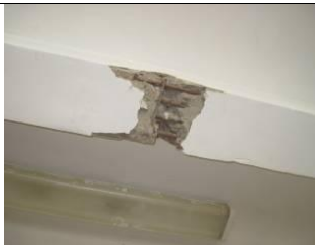
Фото 2.26. Второстепенная балка ж/б перекрытия над пятым этажом в осях «3-7/ В-Е»
