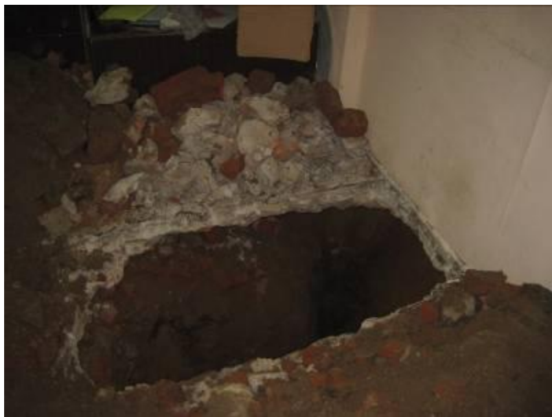
Фото 5.1.17. Фотофиксация шурфа, выкопанного в осях «5/В–Г».
