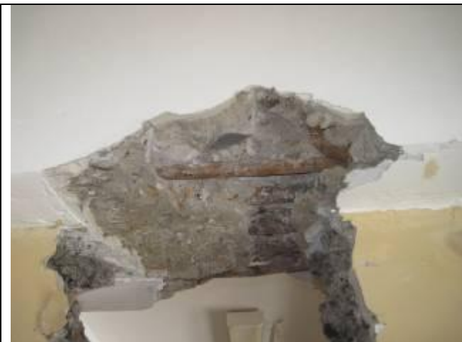
Фото 2.25. Главная балка ж/б перекрытия над пятым этажом в осях «3-7/ В-Е»
