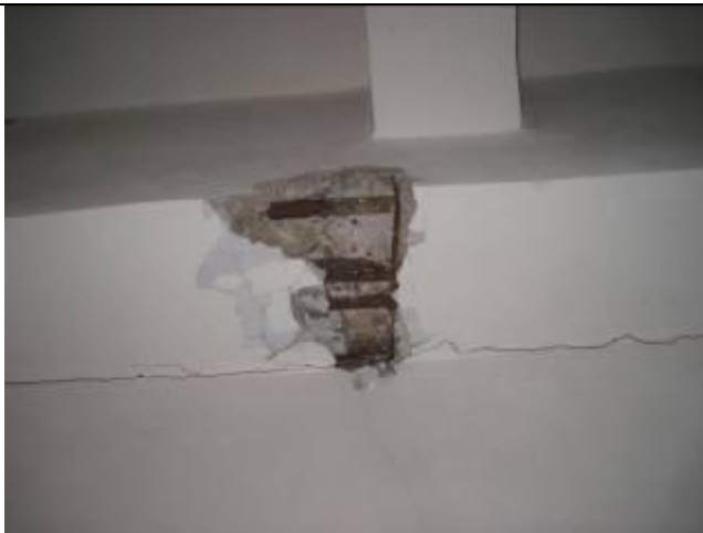
Фото 2.3. Главная балка ж/б перекрытия над первым этажом
