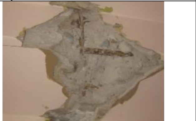
Фото 2.6. Второстепенная балка ж/б перекрытия фойе над первым этажом в осях «1-7/А-Д»
