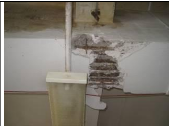
Фото 2.7. Главная балка ж/б перекрытия над вторым этажом в осях «8-11/А-Б, В-Г»
