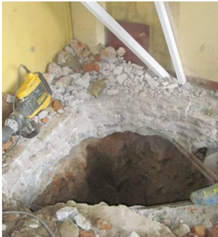
Фото 5.1.13. Фотофиксация шурфа, выкопанного в осях «8–9/В».
