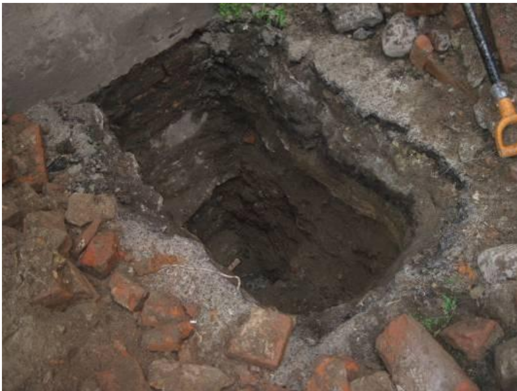
Фото 5.1.7. Фотофиксация шурфа, выкопанного в осях «8–9/Г».
