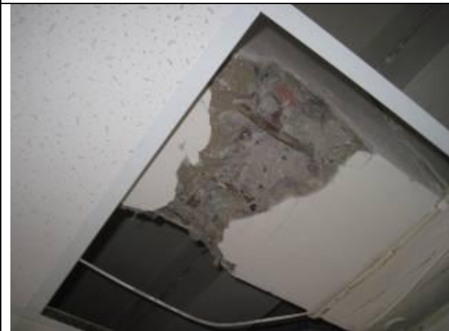
Фото 2.29. Главная балка ж/б перекрытия над пятым этажом в осях «8-9/А-В»
