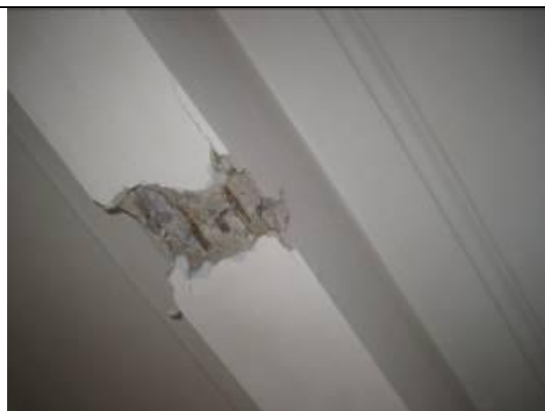
Фото 2.14. Второстепенная балка ж/б перекрытия фойе над вторым этажом в осях «1-7/А-Г»
