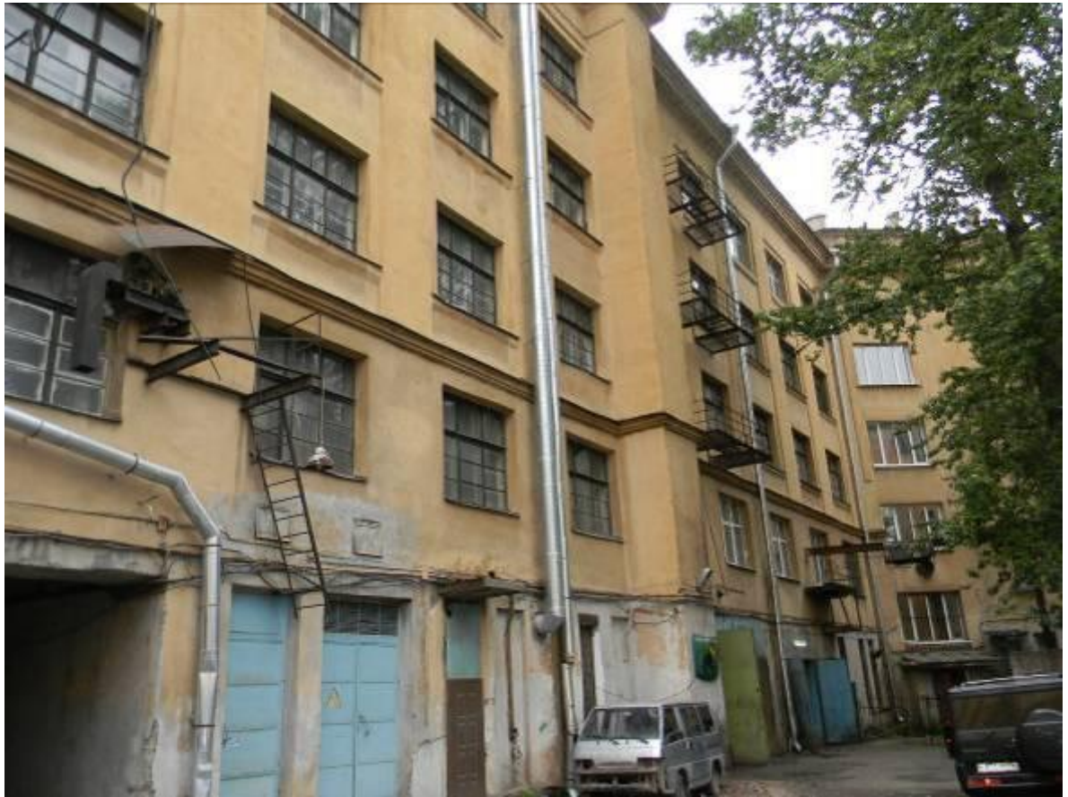
фото 4.2. Фасад по оси «Г»
