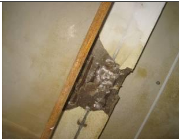
Фото 2.8. Второстепенная балка ж/б перекрытия над вторым этажом в осях «8-11/А-В, Б-Г»
