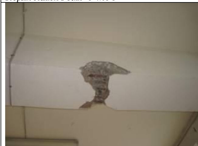
Фото 2.15. Балка ж/б перекрытия над третьим этажом в осях «8-11/А-Б, В-Г»
