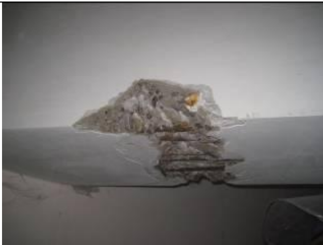
Фото 2.1. Главная балка ж/б перекрытия над подвалам этажом
