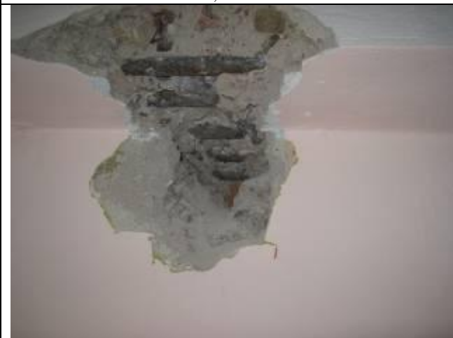
Фото 2.9. Главная балка ж/б перекрытия над вторым этажом в осях «3-6/В-Е»
