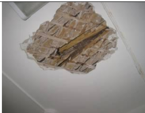
Фото 2.18. Перекрытие над третьим этажом в осях «3-8/А-Г»
