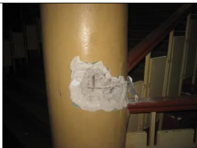
Фото 1.10. Колонна лестничной клетки в осях «6–8/В–Д»
