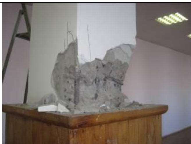
Фото 1.8. Колонна пятого этажа по оси «Б, В»
