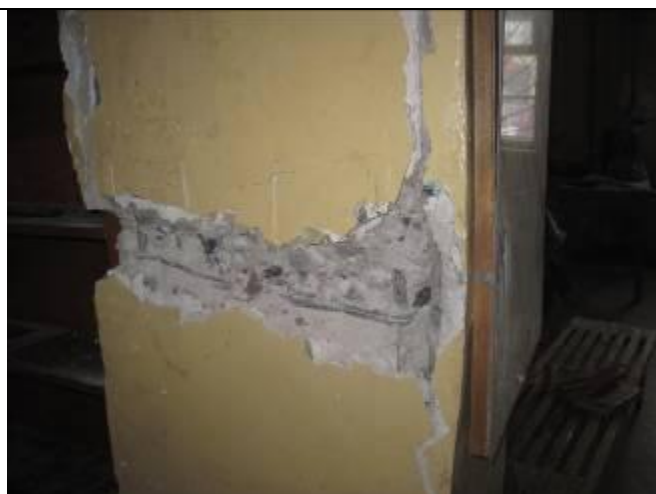
Фото 1.2. Колонна первого этажа по оси «Б, В»
