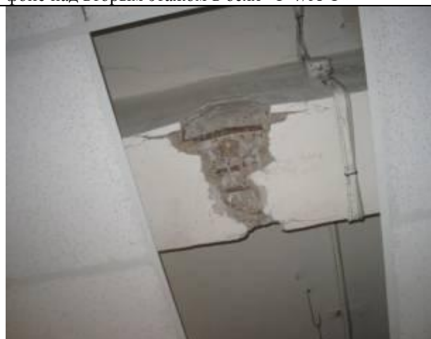
Фото 2.16. Главная балка ж/б перекрытия над третьим этажом в осях «8-11/Б-В»
