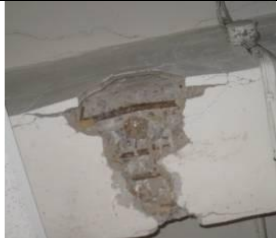
Фото 2.20. Второстепенная балка ж/б перекрытия над третьим этажом в осях «3-7/Г-Е»
