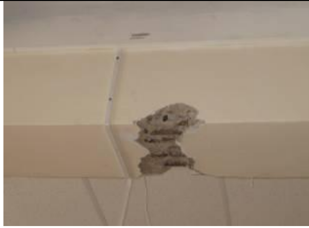
Фото 2.19. Главная балка ж/б перекрытия над третьим этажом в осях «3-7/В-Е»
