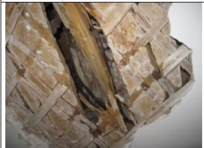
Фото 2.17. Перекрытие над третьим этажом в осях «8-11/А-Г»
