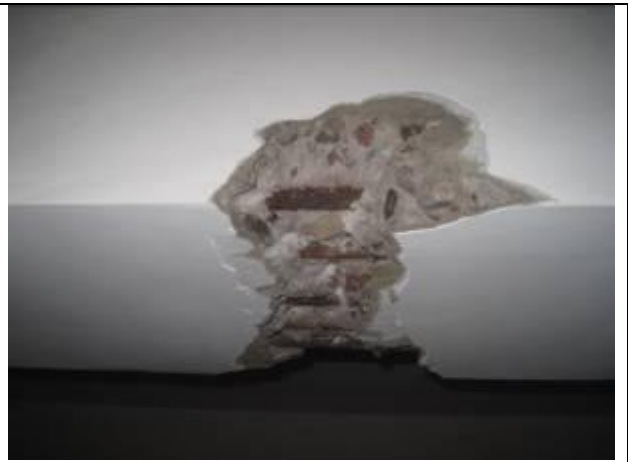
Фото 2.2. Второстепенная балка ж/б перекрытия над подвалом этажом
