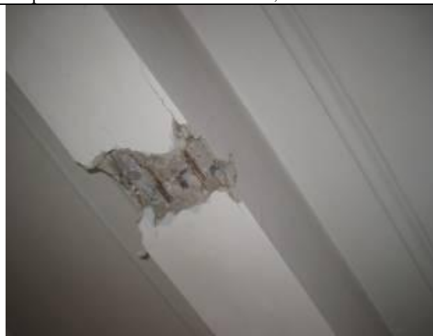
Фото 2.10. Главная балка ж/б перекрытия над вторым этажом в осях «3-6/В-Е»
