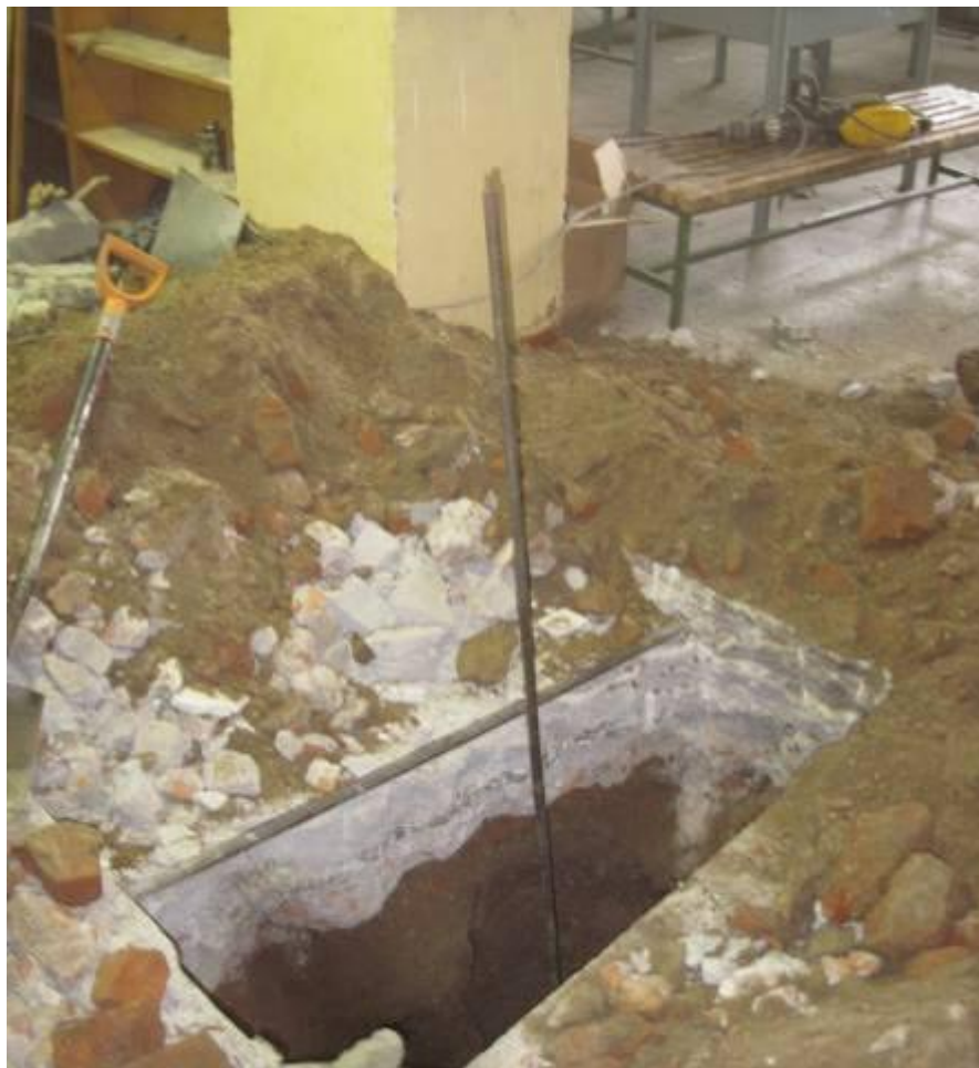
Фото 5.1.11. Фотофиксация шурфа, выкопанного в осях «8–9/Б».
