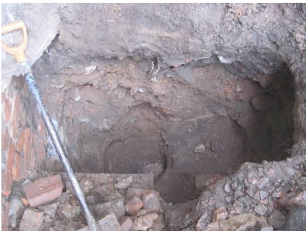
Фото 5.1.9. Фотофиксация шурфа, выкопанного в осях «9–10/Г».
