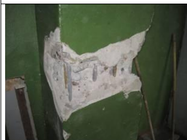
Фото 1.3. Колонна второго этажа по оси «5»
