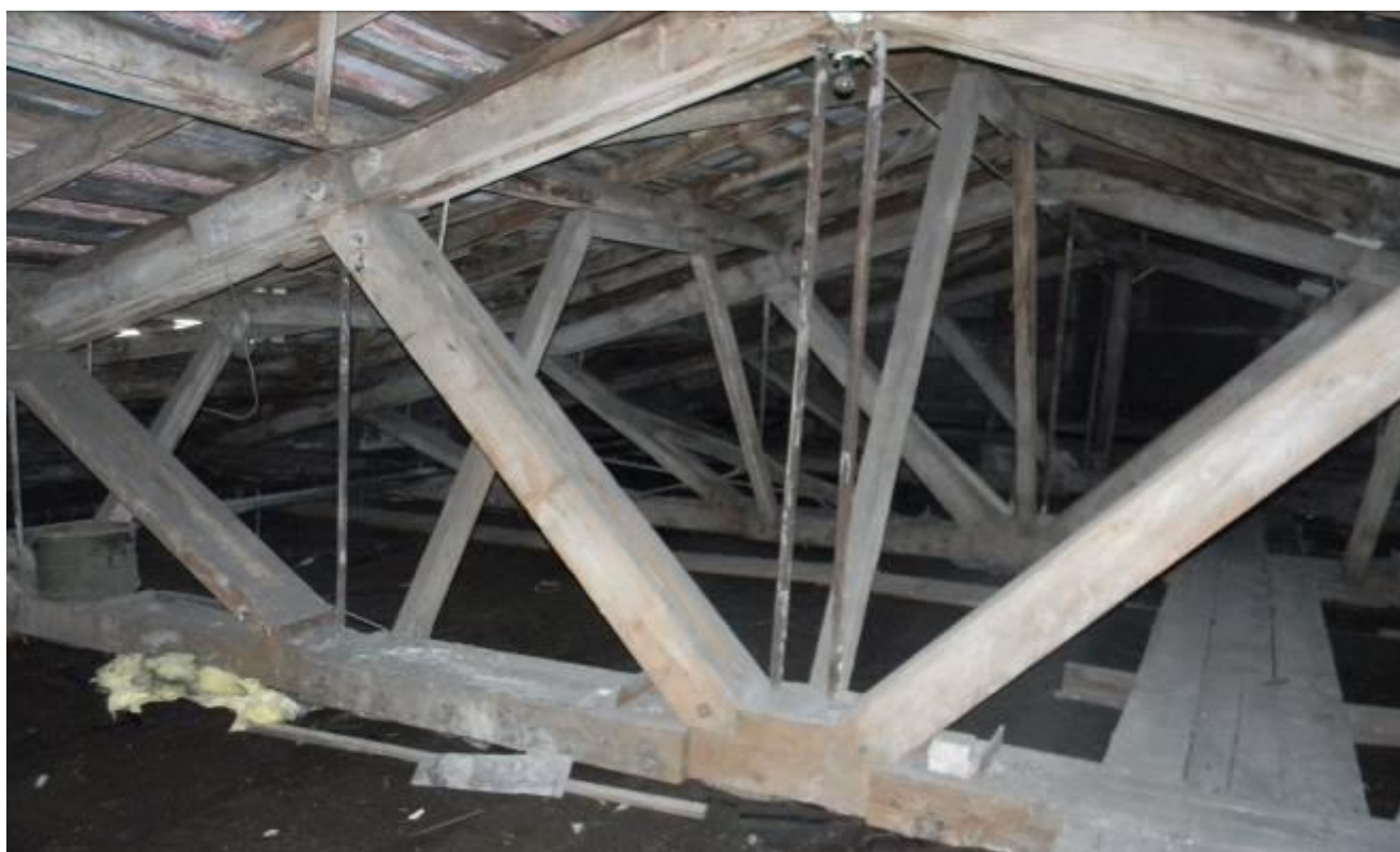
Фото 5.5.2. Фрагмент крыши в осях «9-10/А-Г».
