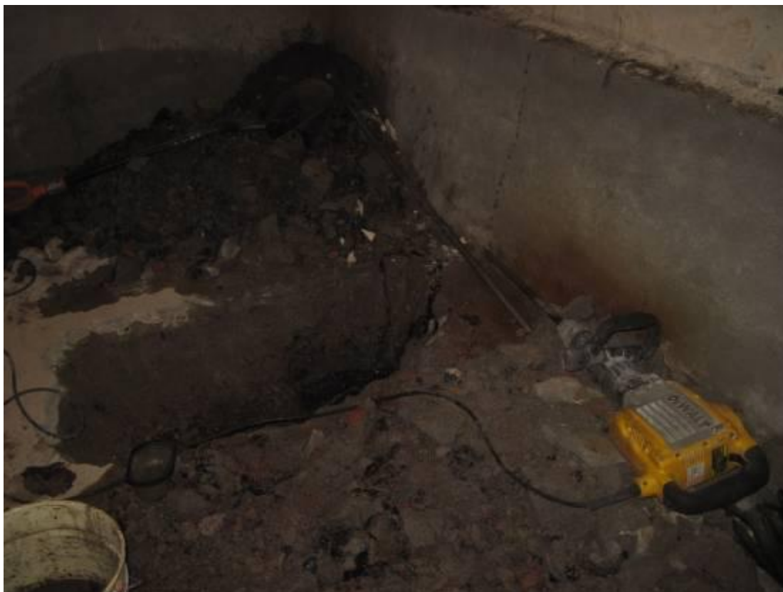
Фото 5.1.3. Фотофиксация шурфа, выкопанного в осях «3/Г–Д».
