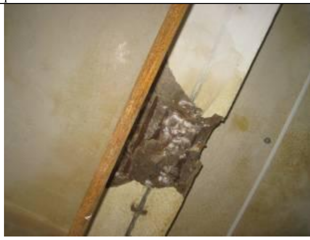
Фото 2.12. Второстепенная балка ж/б перекрытия над вторым этажом в осях «8-11/Б-В»
