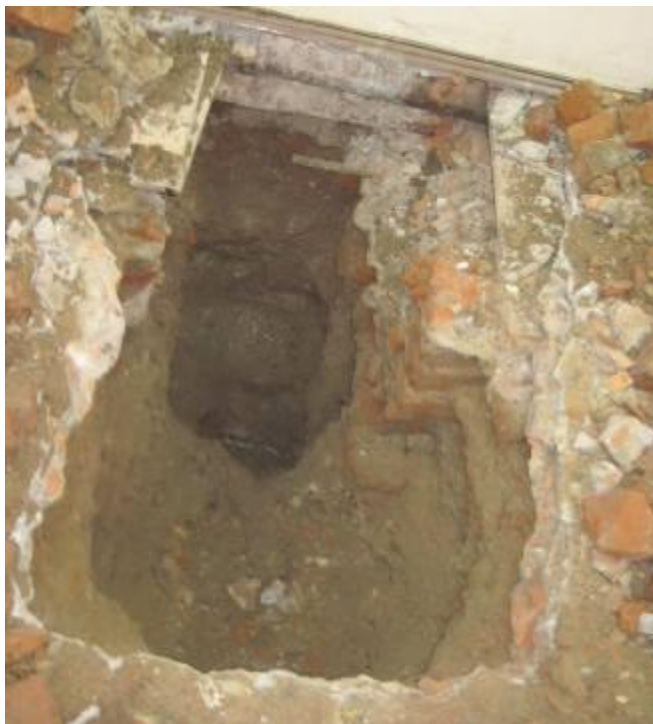
Фото 5.1.15. Фотофиксация шурфа, выкопанного в осях «3/В–Г».
